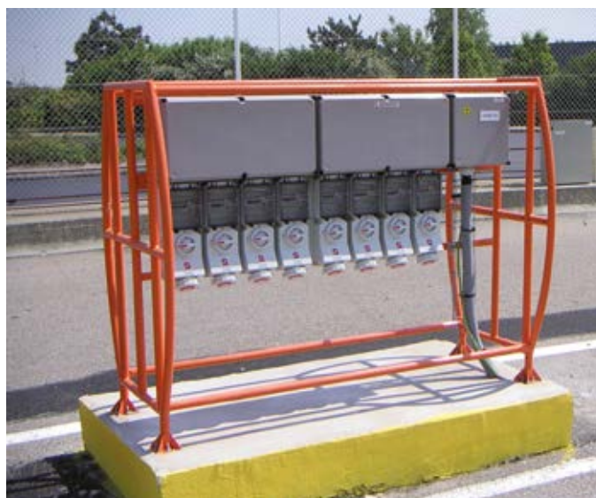
Terminal container , Le Havre, Francia
